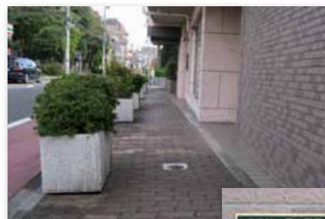
整備したエントランス前と プレート取付け
