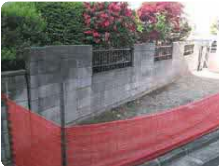
▲相続放棄者が費用をかけ解体し、更地になった
